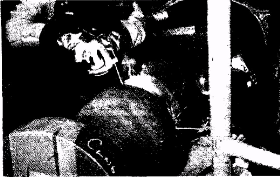
Şekil16.2.- örtülü elektrodlar ile bir buhar santralinin boru donatımının kaynağı.
