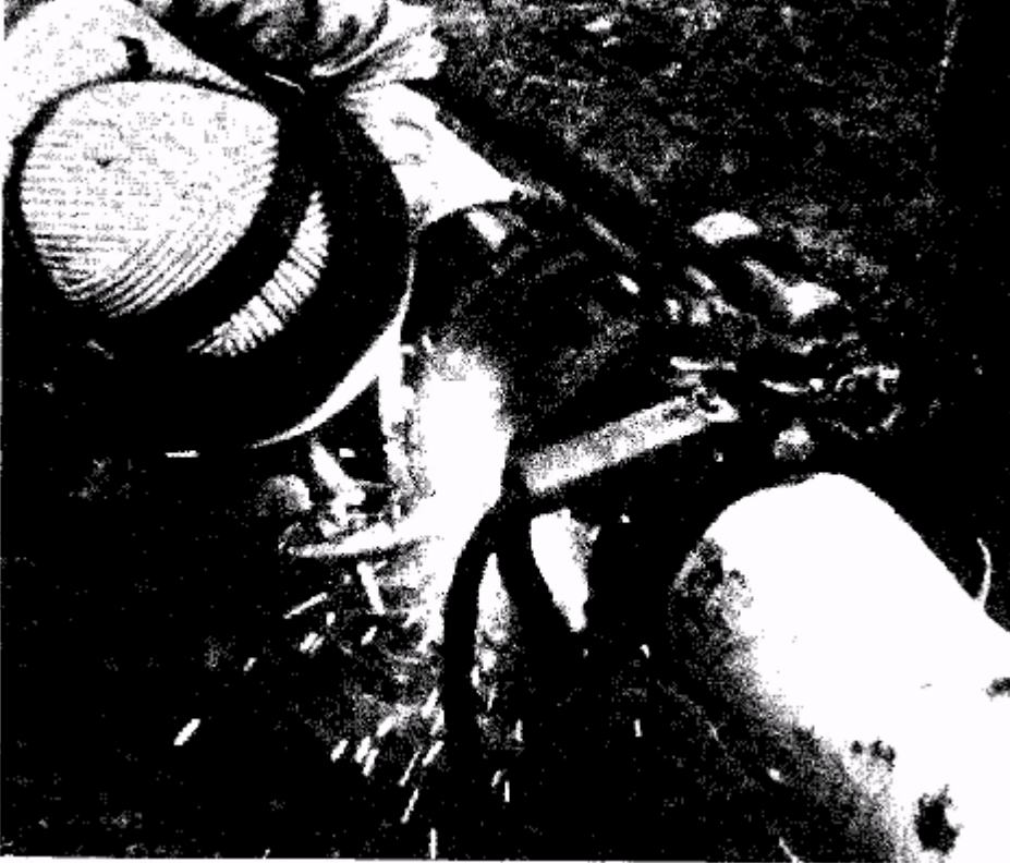
Şekil 105- Küçük çaplı bir boru hattının arazide MIG-MAG yöntemi ile kaynatılması
